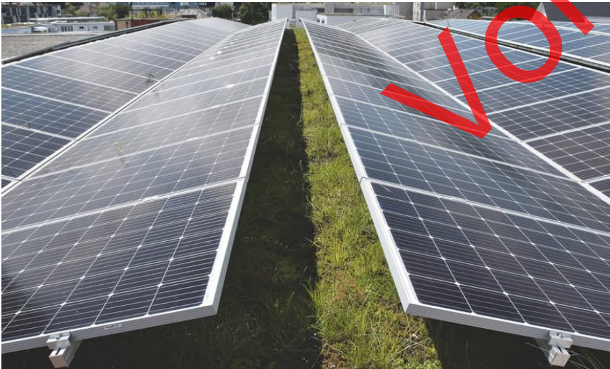
Abb. 121: PVA mit extensiver Dachbegrünung [Ost-West-Ausrichtung]
