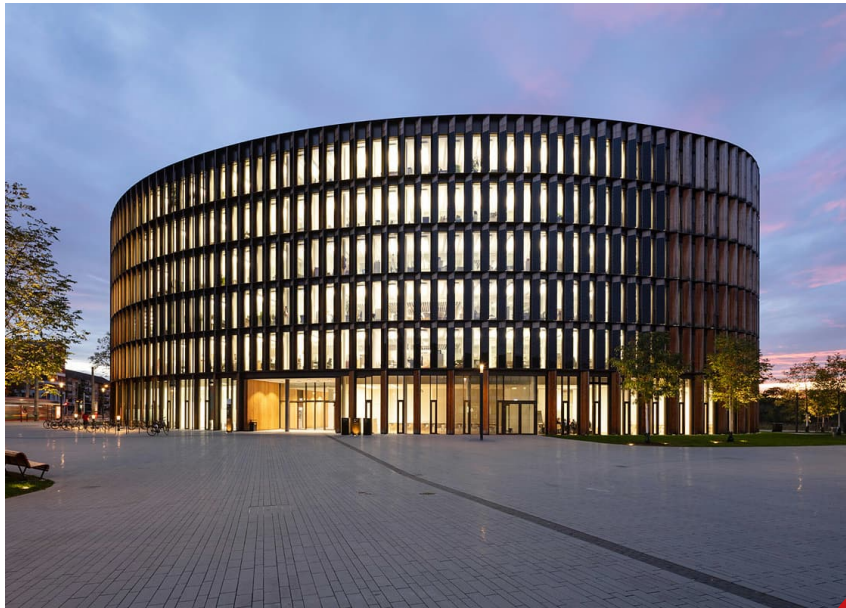
Abb. 124: Photovoltaik-Module in der Fassade des neuen Rathauses in Freiburg im Breisgau [Quelle: tropp-lighting.com / dbz.de]
