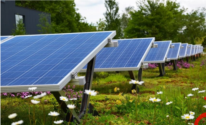
Abb. 121: PVA mit extensiver Dachbegrünung [Ost-West-Ausrichtung]
